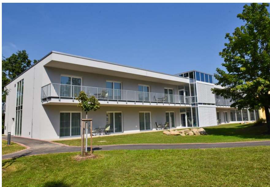
Obrázek 1 – Celkový pohled na nový pavilon
